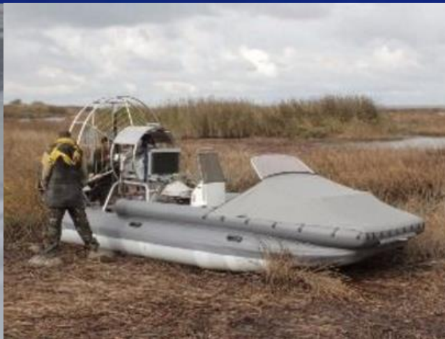
Газопровод Пушкинский р-н, Московская Славянка, \varnothing 520 мм, протяженность 3300 м
